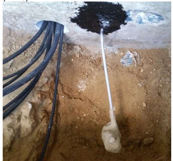
Bild 3: Handschachtung für Schachtgrube
