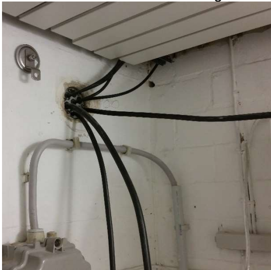
Bild 2: Kabeleintritt im Keller vor dem Einbringen eines Tiefenerders kontrollieren
