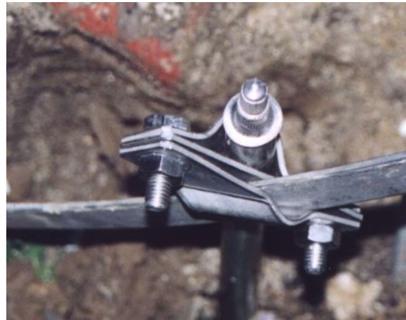
Bild 9: Tiefenerder-Anschlussklemme
